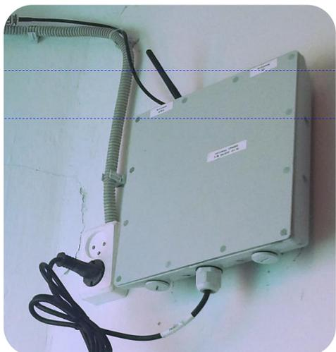
El **concentrador de datos GateWay RF EM4018** está diseñado para **recibir datos por radiofrecuencia** desde los módulos de radio y repetidores de la plataforma EcoMatrix, almacenarlos en memoria no volátil, y transmitirlos al servidor del **Centro de Recolección y Procesamiento de Datos** mediante diversos canales de comunicación, incluidos **GPRS/3G/LTE y Ethernet**.
