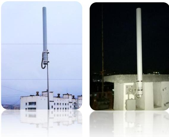
El **Repeater RF EM4003** está diseñado para **ampliar el alcance de recepción RF** de los concentradores GateWay en sistemas automatizados de recopilación de datos de la plataforma EcoMatrix. Recibe señales de radio de los módulos RF conectados a equipos de medición y **las transmite al concentrador GateWay remoto**, garantizando una **comunicación fiable a larga distancia**, incluso en entornos urbanos complejos.
